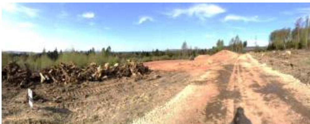
Abbildung 24: Windkraftbaustelle im Naturpark Kaufunger Wald (Hessen, 2016)
