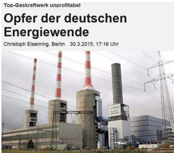
Abbildung 16: Aus der Neuen Zürcher Zeitung vom 30.3.15. Die „effizienteste Turbine der Welt“ wurde eingemottet.
